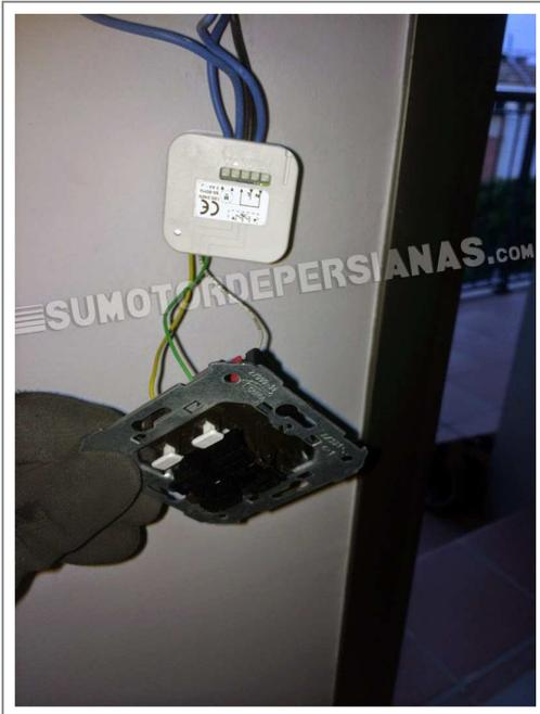
Se sueltan los cables del interruptor y se conectan al receptor RTS mini de Somfy. Tal y como estab interruptor, puedes hacer un croquis. Pero todo va señalado.
