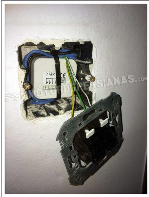
Una vez conectado el lio de cables, se abre la programación en el mini receptor de Somfy para que po frecuencia.
