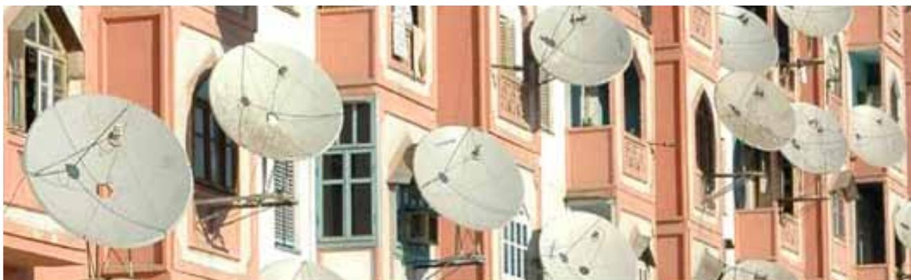
ma aleatoria en las cubiertas. Posteriormente se bajaban los cables vistos de conexión a cada vivienda por los patios o por la fachada cogidos con grapas a los elementos de la fachada. Todos estos equipos también "tuneaban" las cubiertas o terrados así como las fachadas de los edificios.
